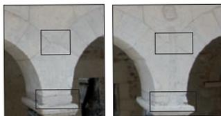
Joins épais et comblé de multiples calages pour permettre l'ajustement entre les arcs et la maçonnerie supérieure
